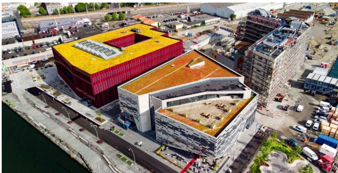
Figur 2.3. Bildene illustrerer sedum-tak i ulike varianter og er hentet fra www.bergknapp.no for inspirasjon.
